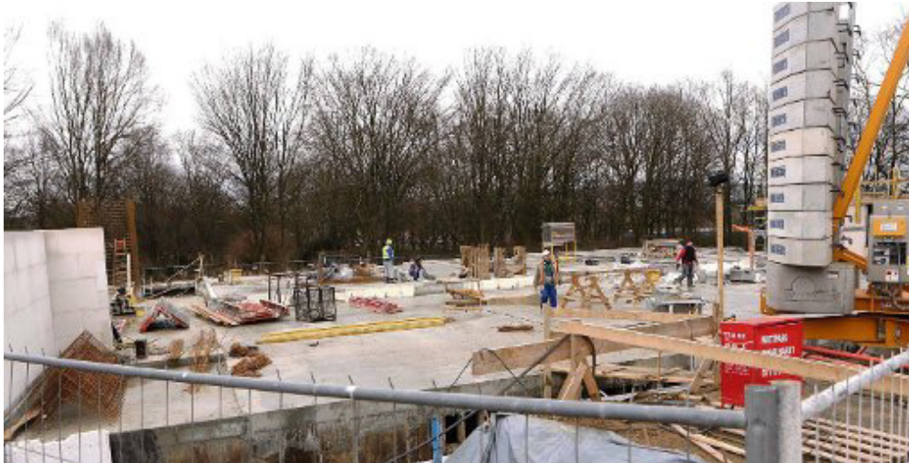
Die Keller von „Woge I“ sind im Rohbau schon fertig. Foto: ZVW
